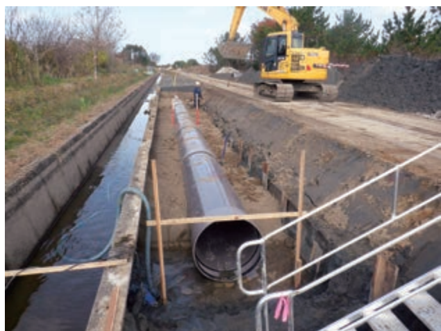
パイプライン工事（A1-4）の施工状況
