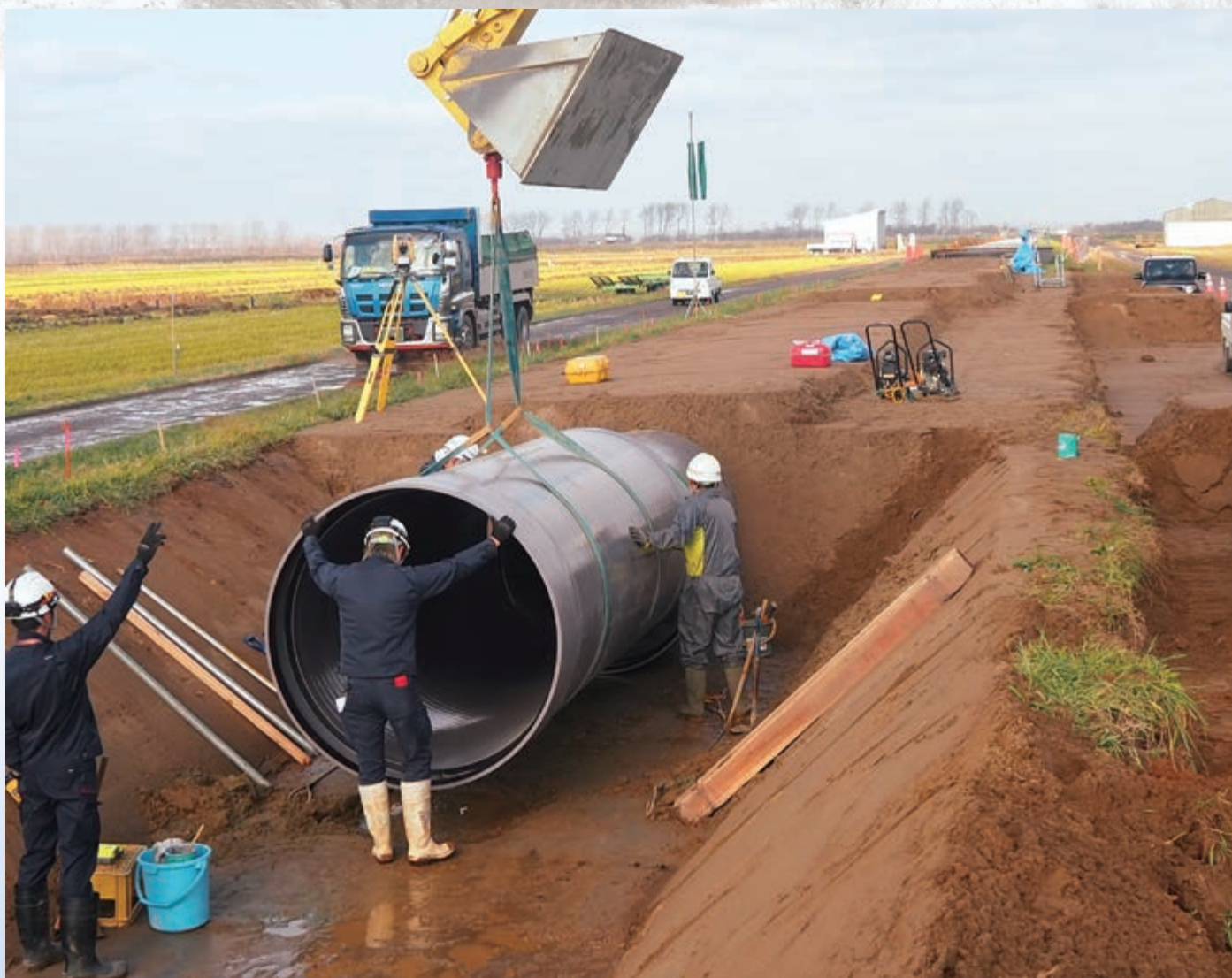
パイプライン化工事が進むF2幹線用水路
