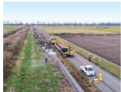
C1-3幹線用水路施工状況
