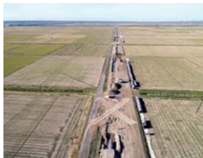
F2幹線用水路施工状況
