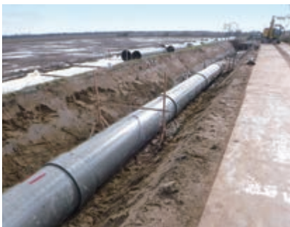
A1-4幹線用水路施工状況
