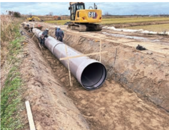
パイプライン工事（A1-4）の施工状況
